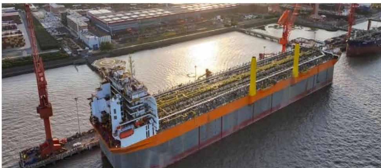
230 万桶通用型 FPSO
